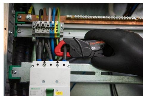
**! Szczelina** (utworzona z powierzchni czołowych rdzenia) powinna być utrzymywana w idealnej czystości.
